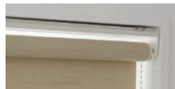
シールドがない状態
